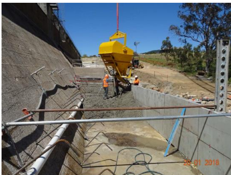
First Buttress Pour
