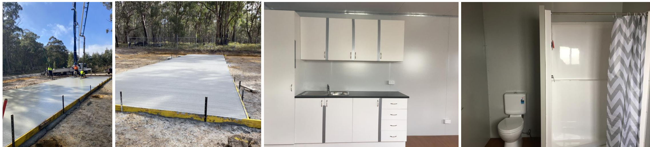
Figure 1, 2, 3 & 4 Slab pour at Boonoo Boonoo & Site Office internals July
